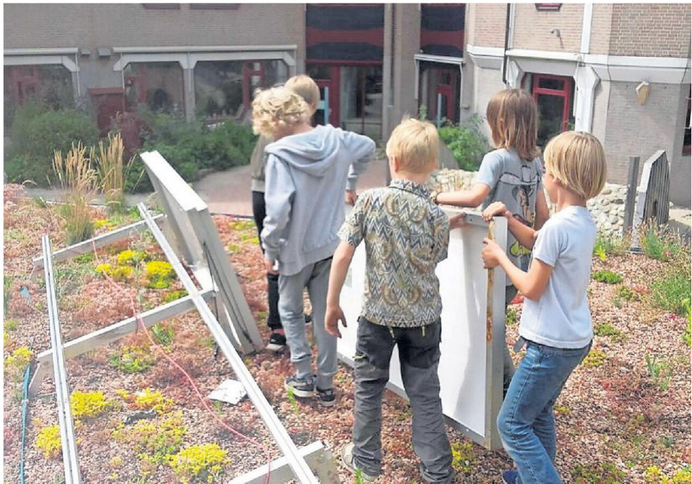
Leerlingen helpen de eerste 15 panelen te plaatsen op het groene dak van de school.
